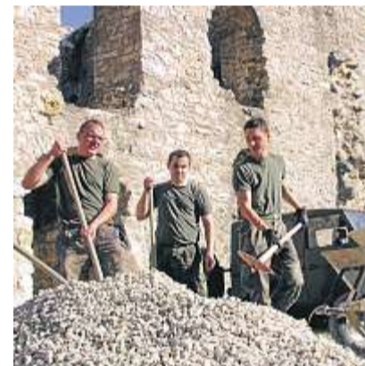
Soldaten aus Hemau, später aus Regensburg, halfen bei den Bauarbeiten oder entfernten Gebüsch.
