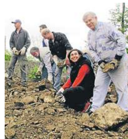
Die meisten Steine, die für die Sanierung der Mauern verwendet wurden, wurden im Burggraben ausgebuddelt.
